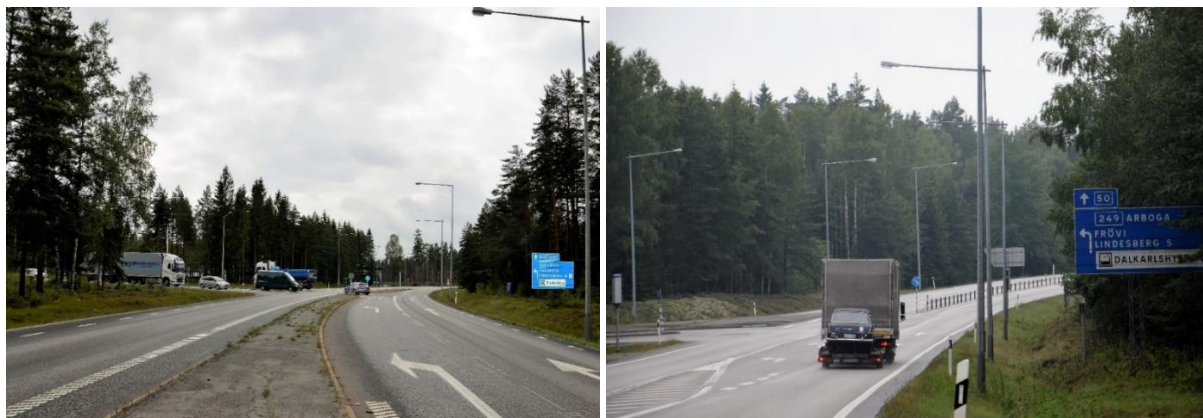
Figur 44 och 45. Fotot till vänster är taget vid anslutningen av Rv68 (Norra avfarten mot Lindesberg). Fotot till höger är taget vid den södra infarten till Lindesberg.
