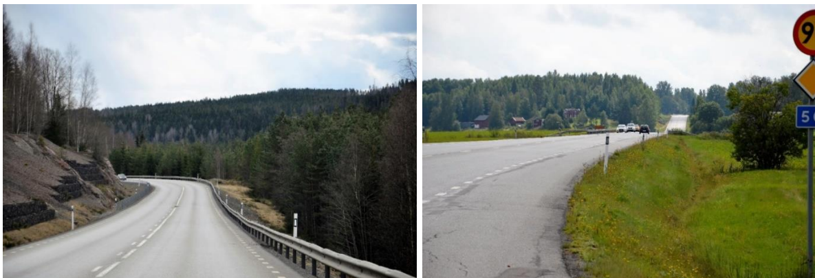
Figur 37 och 38. Fotot till vänster. Vid byggandet av förbifart Kopparberg användes s.k. gabioner som stödmur för släntstabilisering. Fotot till höger är taget vid Östra Löa. Bred vägsektion/13-metersväg och gynnsamt sidoutrymme för utbyggnad av 2+1-väg.
