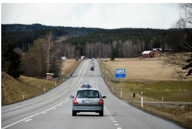
Figur 39. Fotot taget i norrgående riktning strax söder om Ö Löa. Som tydligt framgår av bilden finns det ett lämpligt sidoutrymme för utbyggnad av 2+1-väg.
