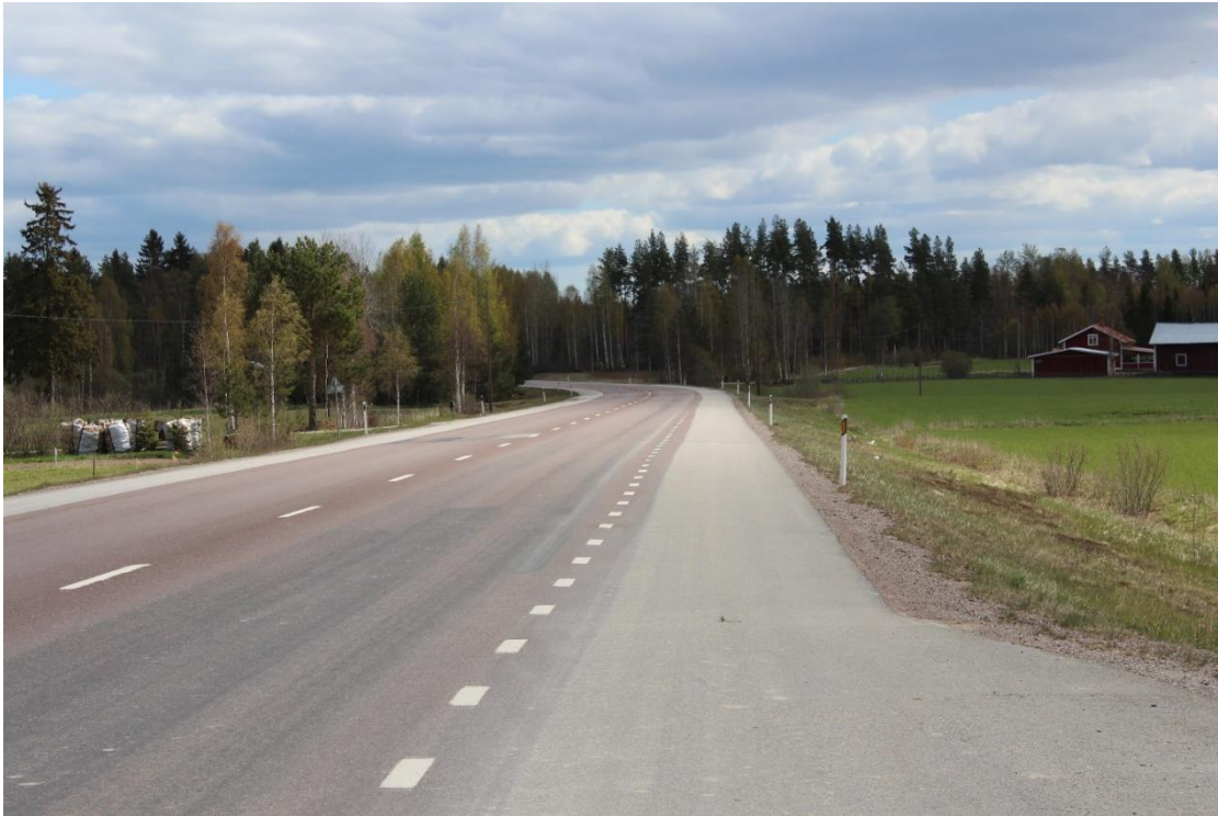
Figur 33. Fotot taget strax öster om anslutningen av vägen mot Runemo. Riktning mot Bollnäs. Här börjar också den breda vägsektionen. Men vägrenarnas bärighetsstandard är inte närmare undersökt inför föreslagen utbyggnad av 2+1-väg.
