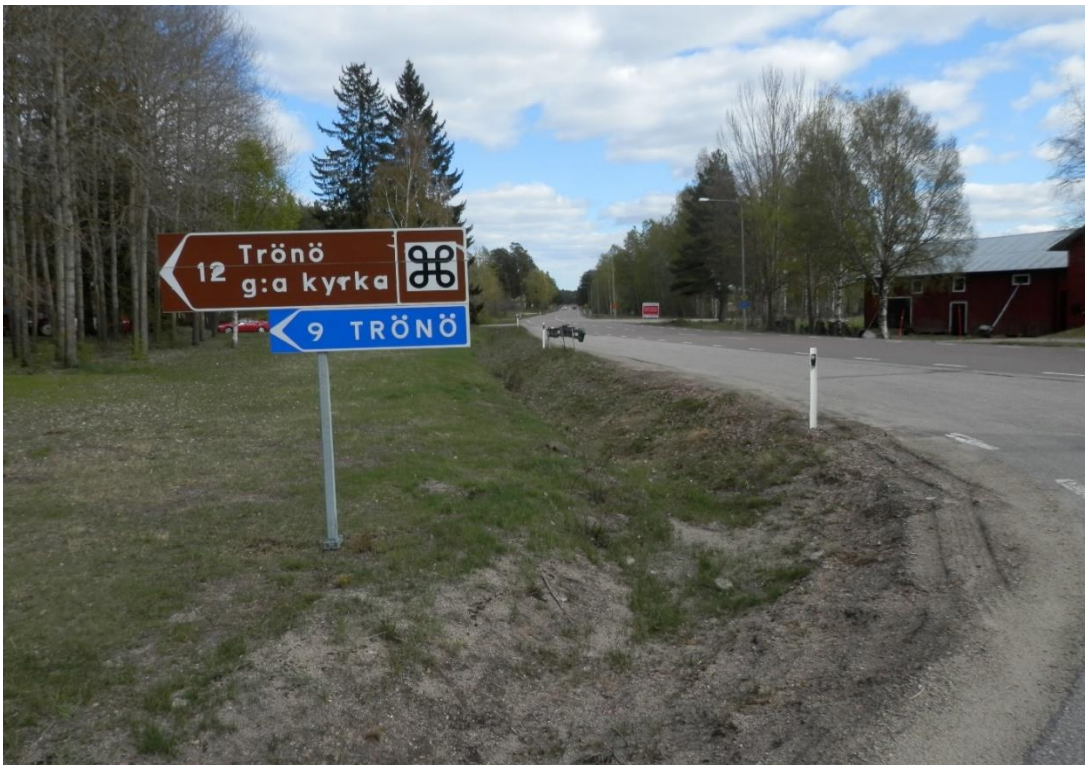
Figur 47. I Glössbo finns anslutningen av Trönövägen. Öster om denna korsning börjar det projekt som avser ombyggnad av sträckan Glössbo – Söderhamn.
