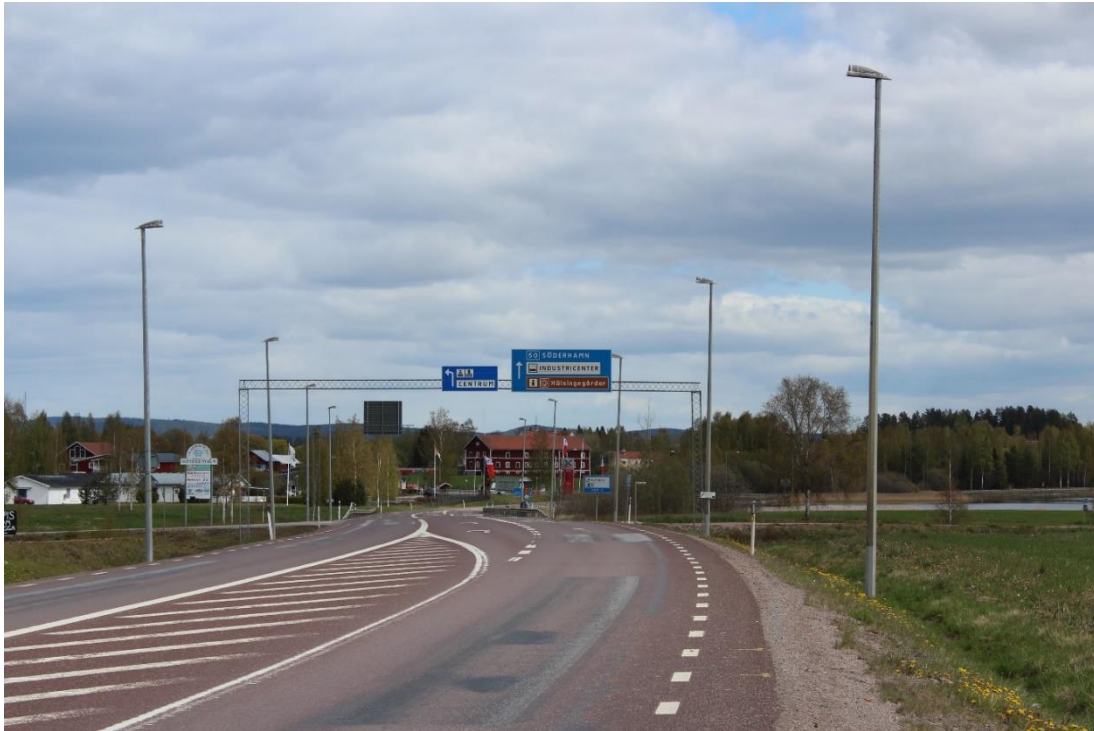
Figur 30. Fotot är taget vid östra infarten till Alftra (Runemovägen Lv619). Den aktuella delsträckan slutar vid samma vägs (Lv619) anslutning mot Rv50 väster om Söräng.
