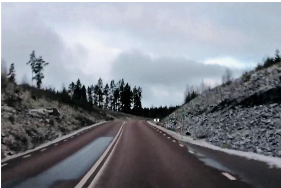
Figur 25. Fotot visar en ordentlig skärning. Överskottsmassor har använts för att fylla ut passager över myrar (upp till 2 meter) och har på så sätt skapat massbalans! Omfattande bärighetsåtgärder är genomförda på denna delsträcka.
