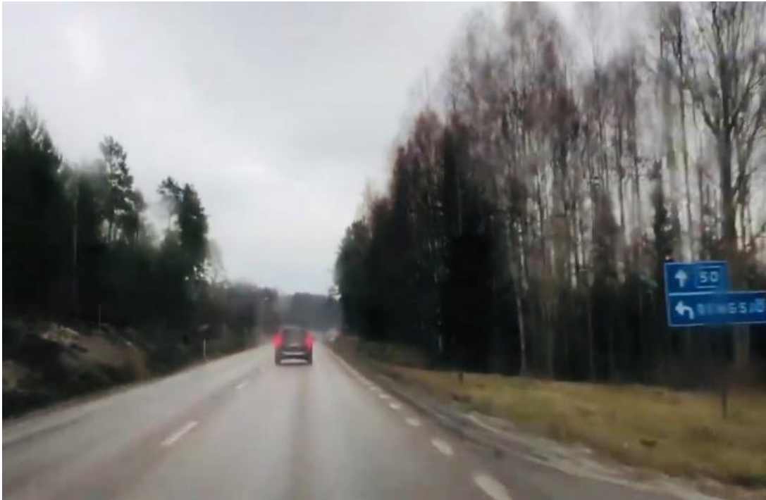
Figur 44. Fotot är taget vid anslutningen av vägen mot Rengsjö. Som framgår av tabellerna ovan är den förhärskande vägbredden 8-10 m. Detta tillsammans med förhållandevis låg trafik innebär att den s.k. prioriteringsfaktorn för trafiksäkerhet – PF (TS) riskerar att bli hög.
