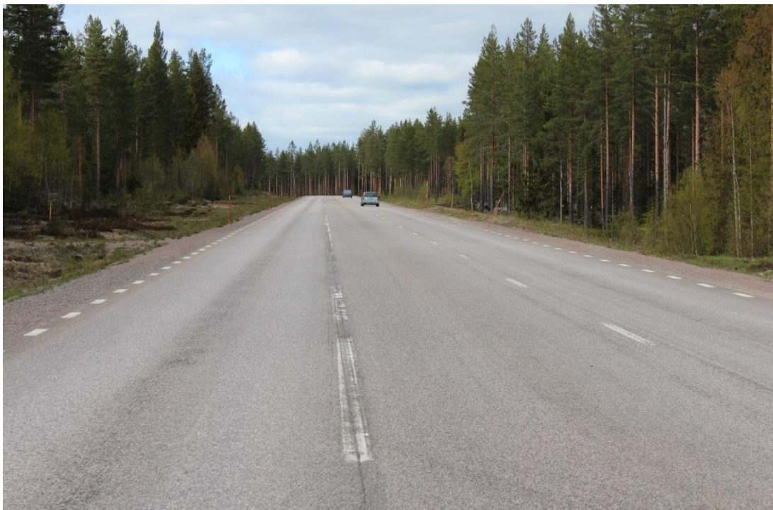
Figur 23. Norr om Svabensverk går vägen starkt uppför i ett flertal backavsnitt. Trots relativt låg trafikbelastning har vägen här försetts med stigningsfält!
