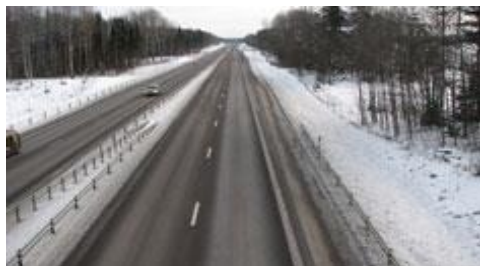
Figur 6. Illustration av standardklass 1. Källa: Trafikverket
