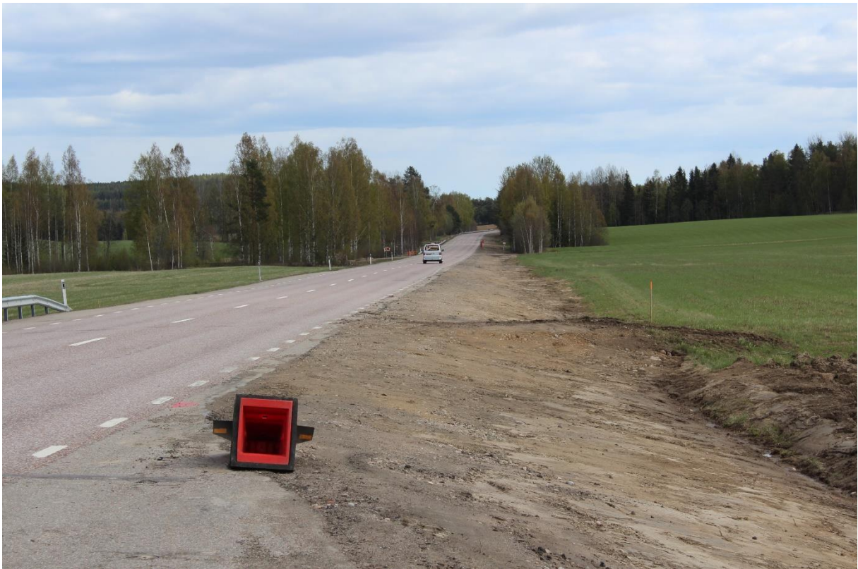
Figur 51. Pågående vägarbete på delen Glössbo – Söderhamn innebär bl.a. att befintlig vägren tas bort och släntning sker direkt mot asfaltkant. En mycket ovanlig åtgärd! Vägsektionens ursprungliga utseende framgår av föregående bild. Från att trafiken mellan Glössbo och Mohed är relativt låg är trafiken in mot Söderhamn högre med ÅDT ca 8 000.
