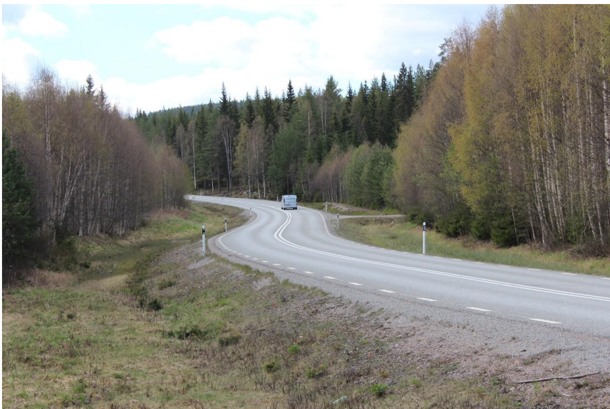
Figur 21. Fotot är taget norr om Lamborn och visar att standarden på vägen höjts ordentligt genom bärighetshöjande åtgärder. Men linjeföringen är fortfarande problematisk – heldragna mittlinjer och således omkörningsförbud.
