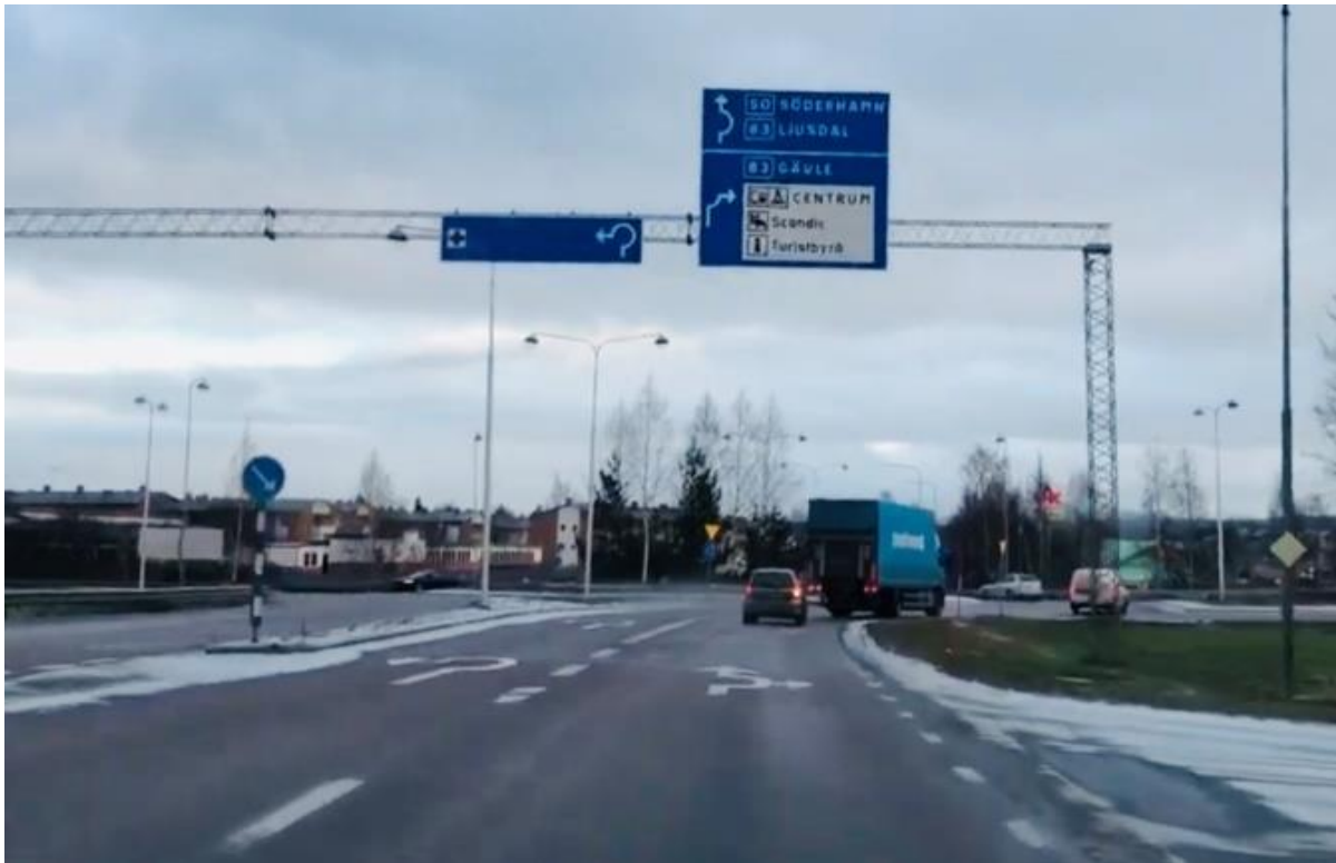
Figur 36. Fotot är taget strax före cirkulationsplatsen där Rv50 och Rv83 får gemensam sträckning. Hög trafikbelastning – ÅDT ligger på drygt 16 000 f/dygn. Detta foto är taget i november (dåligt väder) 2018.
