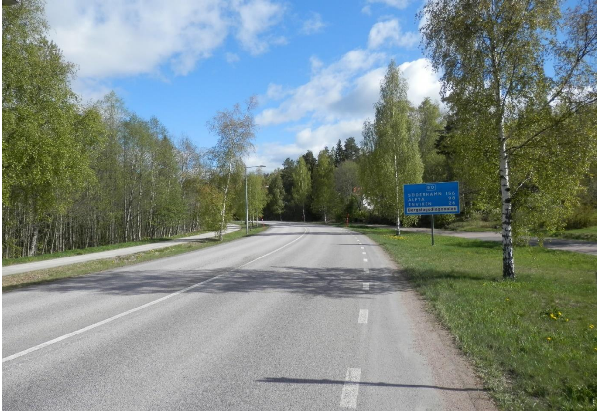
Figur 17. Fotot är taget strax norr om anslutningen av E16/Rv50 i Falun. Här är ÅDT 2 650. En lämplig trafiksäkerhetshöjande åtgärd som föreslås är mitträffling.
