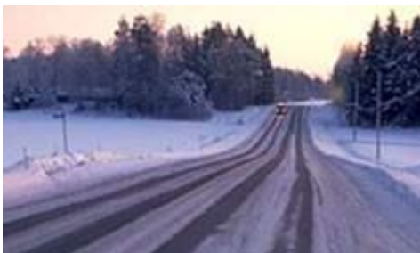
Figur 8. Illustration av standardklass 3. Källa: Trafikverket.
