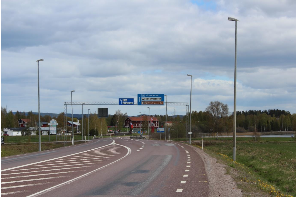
Figur 30. Fotot är taget vid östra infarten till Alfita (Runemovägen Lv619). Den aktuella delsträckan slutar vid samma vägs (Lv619) anslutning mot Rv50 väster om Söräng.
