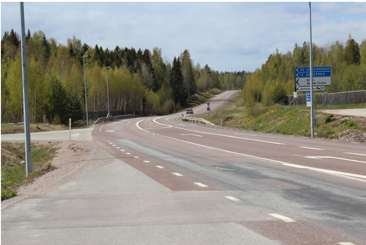
Figur 31. Anslutningen av vägen mot Gruvberget.
